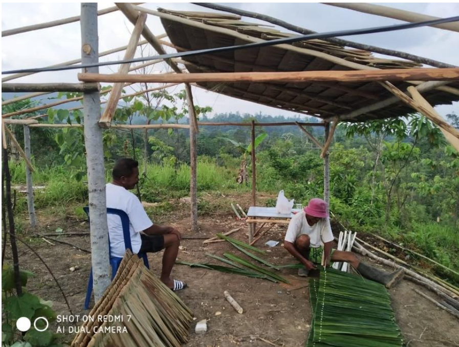
Dakbedekking in de maak, van atap, aangeregen sagopalmladeren, als vervanging van de kapotte tentzeildoek. Traditionele oude ambacht is weer terug. 24 oktober 2019
